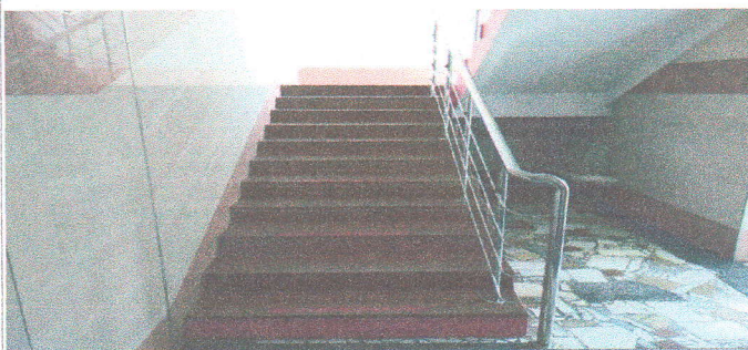
Фото № 55— лестница (левый вход)
