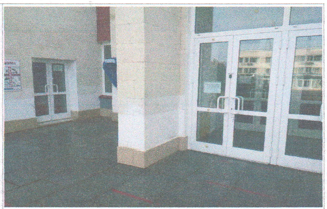
Фото №30 — Вход в здание центральный и эвакуационный
