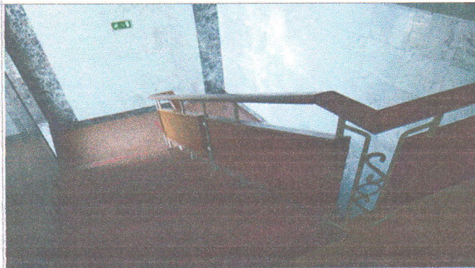
Фото № 58— лестница (правый выход)
