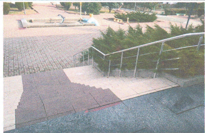
Фото №27 — Вход (выход) в здание главный (центральный)
