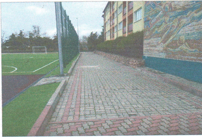
Фото №17 – Пути движения по территории корпус №5
