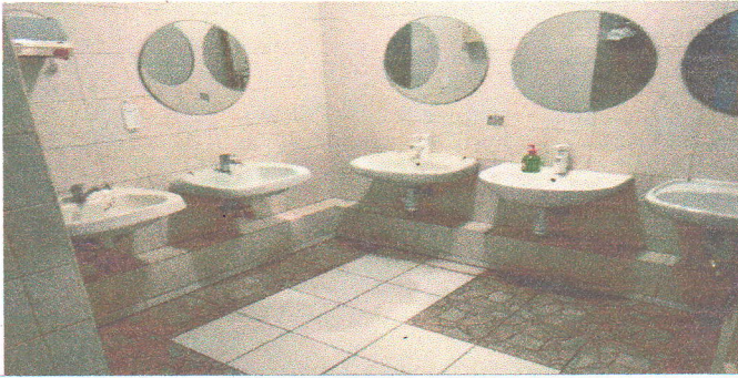
Фото № 49 — Санитарно-гигиеническое помещение (раковины)
