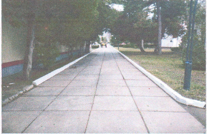
Фото №12 – Пути движения по территории к корпусу №2
