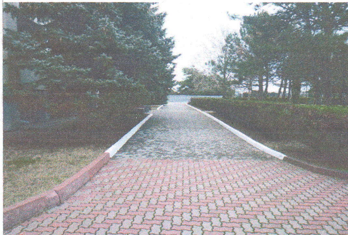
Фото №15 – Пути движения по территории корпус №4
