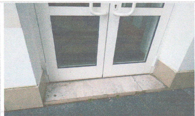
Фото №31 - Вход в здание эвакуационный (порог)
