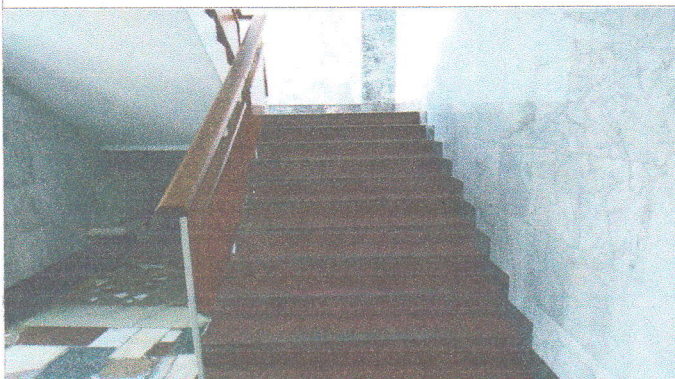
Фото № 57— лестница (правый вход)
