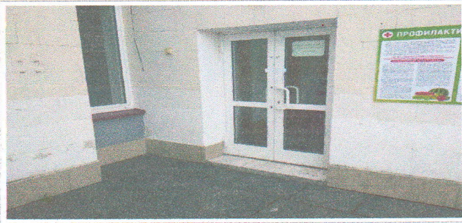
Фото №54 — эвакуационный (вход-выход) с правой стороны
