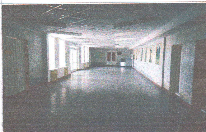
Фото №36 - Пути движения внутри здания холл
