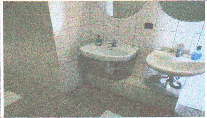
Фото №46 — Санитарно-гигиеническое помещение (раковины)
