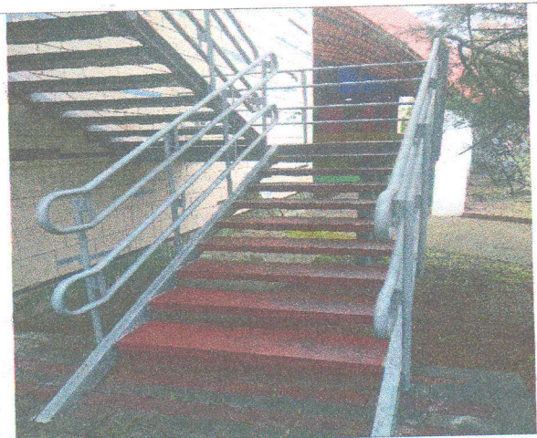
Фото №30 — лестничный марш на второй этаж
