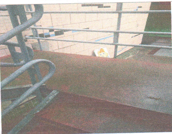
Фото №31 — площадка лестничного марша
