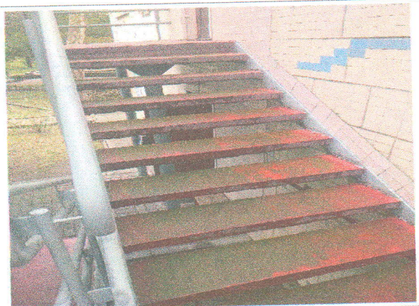
Фото №32 — лестничный марш на второй этаж
