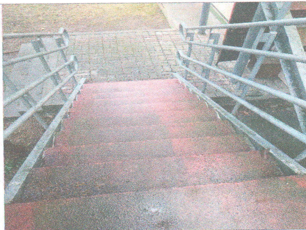
Фото №34 – лестничный марш
