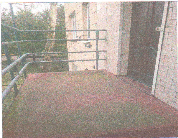
Фото №33 – площадка перед входом на второй этаж
