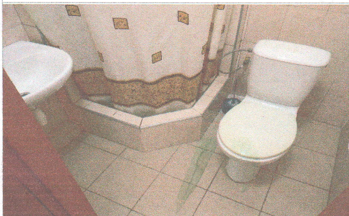
Фото № 63- Санитарно-гигиеническое помещение в номере
