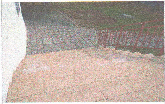
Фото №28 — лестница с площадкой центрального входа (правая сторона)
