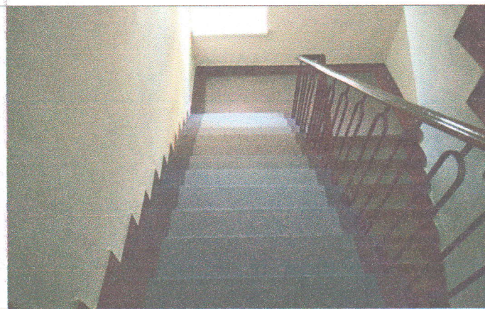
Фото № 46- лестничный марш эвакуационного выхода
