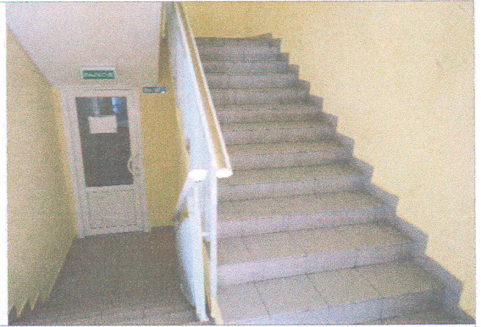
Фото №34 – выход эвакуационный с левой стороны
