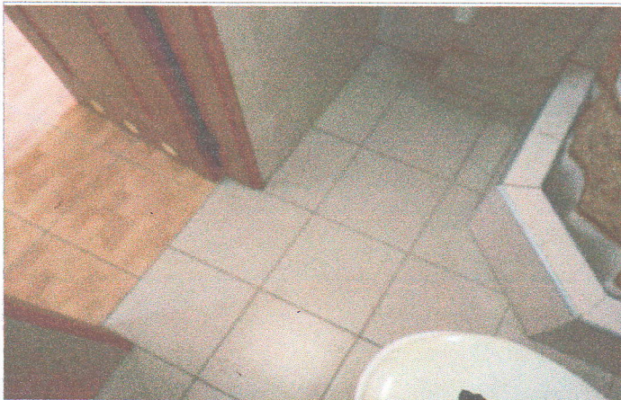
Фото № 65- Санитарно-гигиеническое помещение в номере
