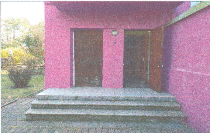
Фото № 49- вход в корпус запасной (эвакуационный)
