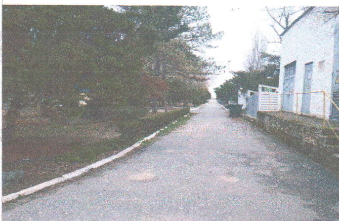
Фото №11 – Пути движения по территории к корпусу № 8; №7; №6; №5
