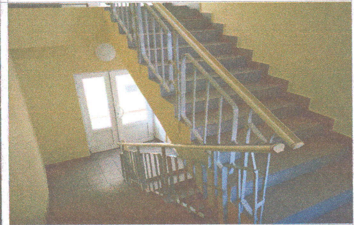
Фото №38- лестничный марш третьего этажа
