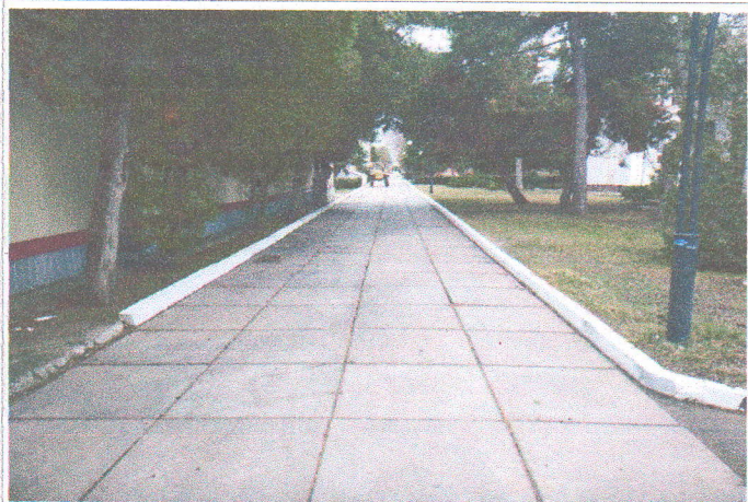
Фото №12 – Пути движения по территории к корпусу №2; №4.
