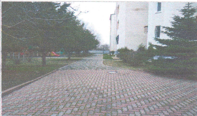
Фото №14 – Пути движения по территории корпус №4
