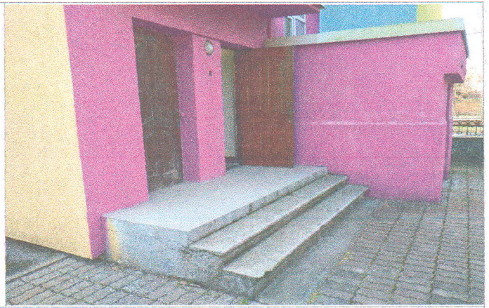
Фото № 50- вход в корпус запасной (эвакуационный)
