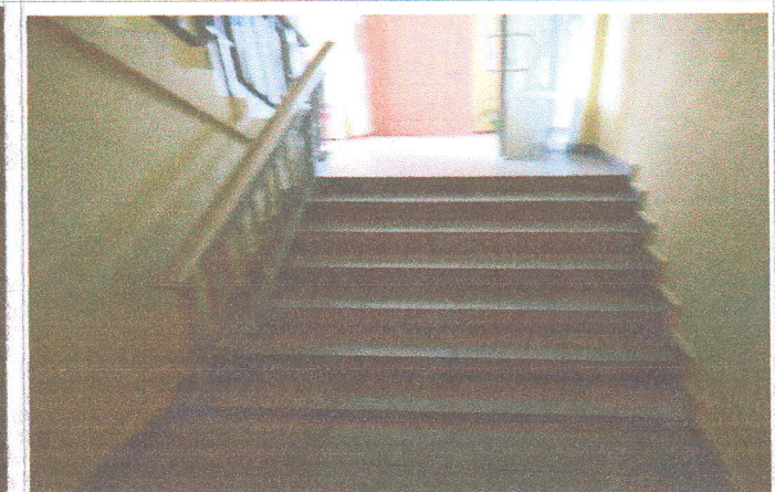
Фото № 40 – лестничный марш эвакуационного выхода
