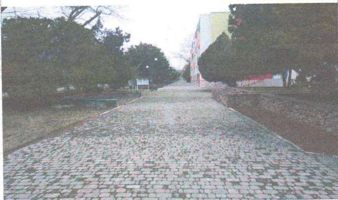
Фото №19 – Пути движения по территории корпус №6; №5
