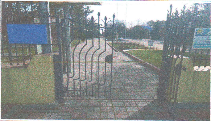
Фото №3 – Вход на территорию центральный со стороны ул. Аллея Дружбы 31, КПП №1
