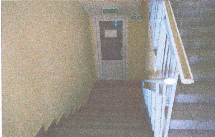
Фото № 51- эвакуационный выход с левой стороны корпуса
