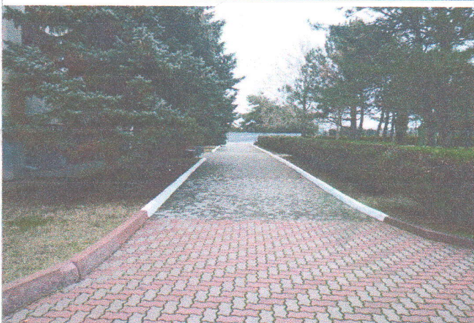
Фото №15 – Пути движения по территории корпус №4
