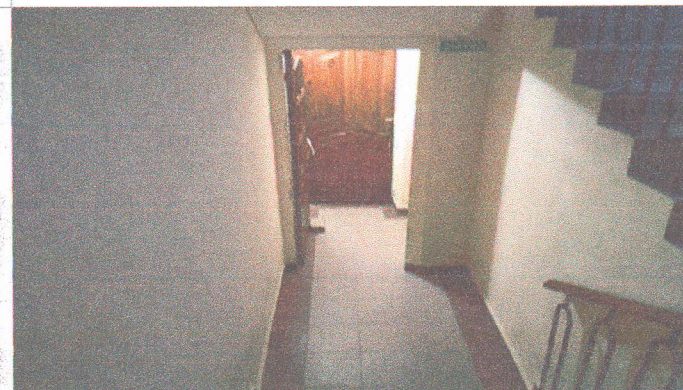
Фото № 48- эвакуационный выход с правой стороны
