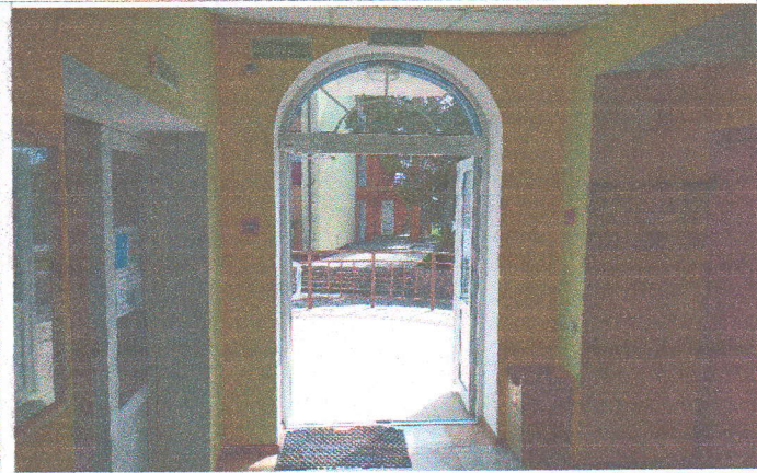
Фото №30 – дверь выход из корпуса (центральный)
