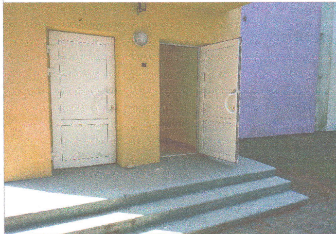
Фото № 53- эвакуационный вход в корпус с левой стороны
