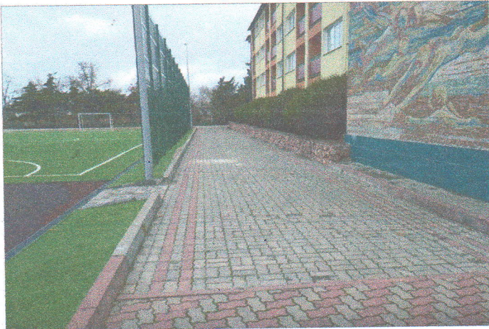
Фото №17 – Пути движения по территории корпус №5
