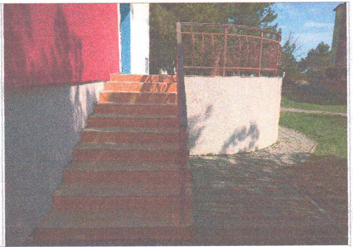
Фото №26 — вход в корпус №6 (с левой стороны)
