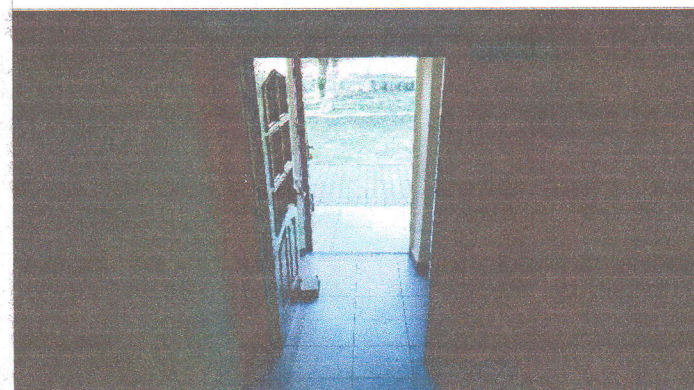
Фото № 47- эвакуационный выход с правой стороны
