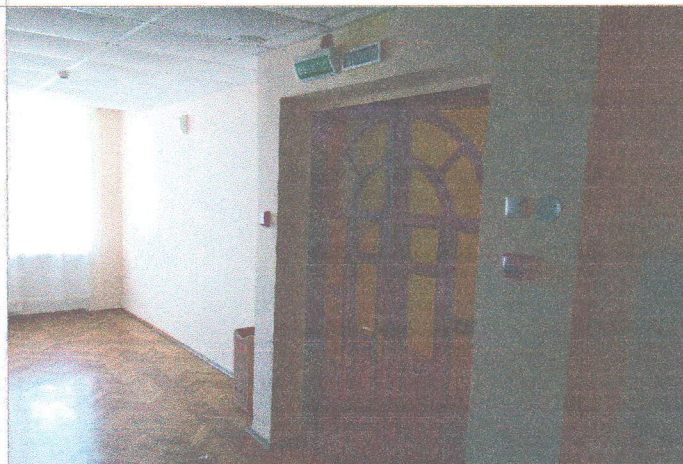
Фото № 44- двери эвакуационного выхода третьего этажа
