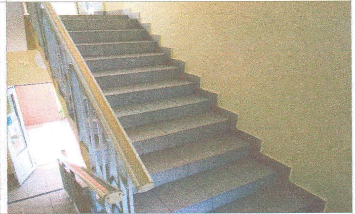
Фото №36 - лестничный марш второго этажа
