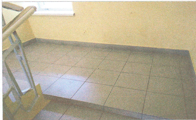
Фото №35 - площадка лестничного марша второго этажа
