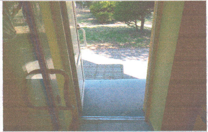
Фото № 52- эвакуационный выход с левой стороны корпуса
