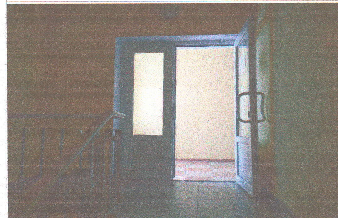
Фото №39 – входная дверь третьего этажа
