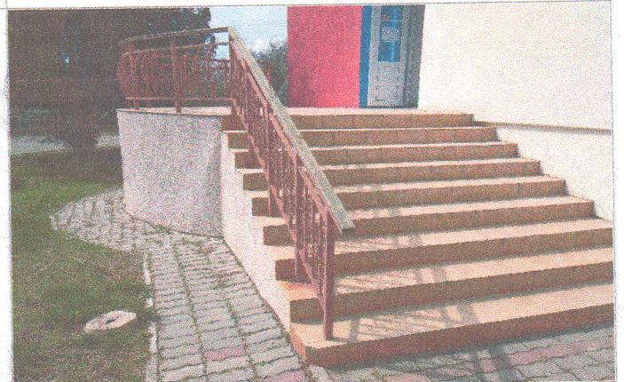
Фото №24 – вход в корпус №6 (центральный)
