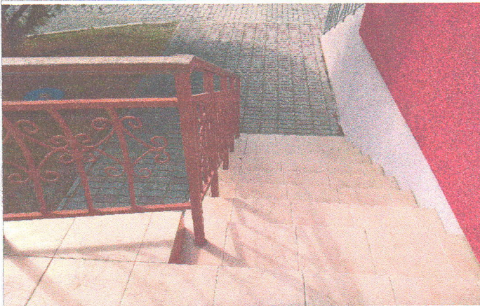
Фото №27 — лестница с площадкой центрального входа (левая сторона)
