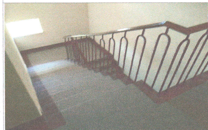
Фото № 45- лестничный марш эвакуационного выхода
