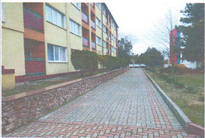
Фото №16 – Пути движения по территории корпус №5
