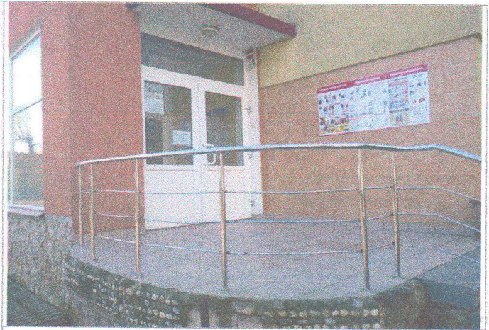
Фото №26 — Площадка и дверь (центральный вход)
