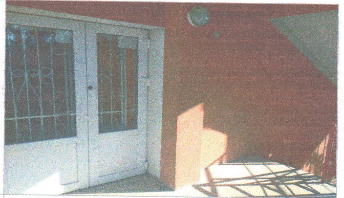
Фото № 42 - дверь в здание (эвакуационная)
