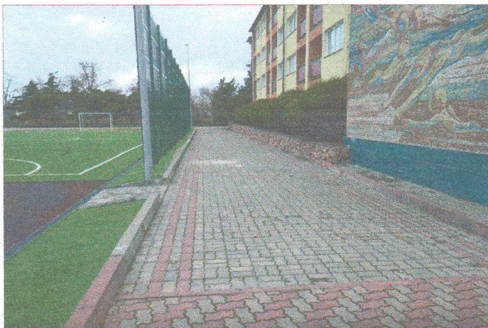
Фото №17 – Пути движения по территории корпус №5
