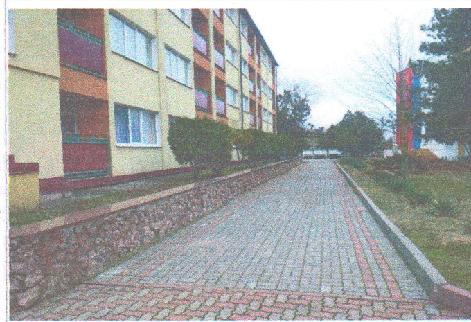
Фото №16 – Пути движения по территории корпус №5
