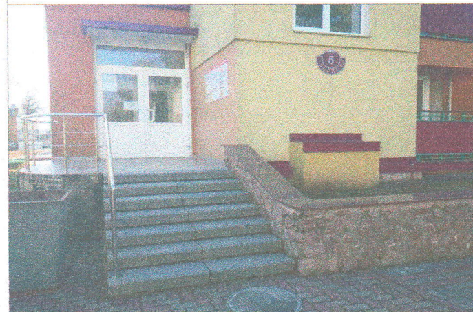
Фото №23 – вход в корпус №5 (центральный)
