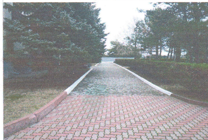
Фото №15 – Пути движения по территории корпус №4
