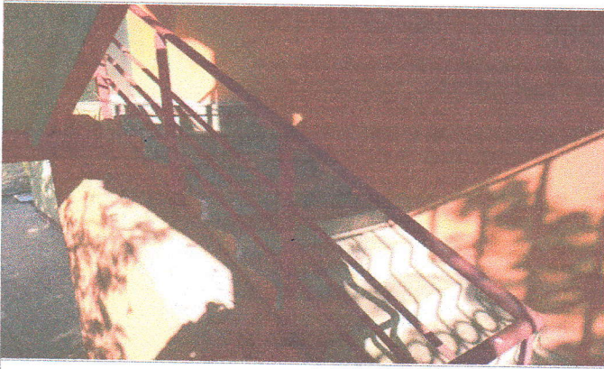
Фото № 41 – лестница эвакуационная
