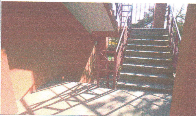
Фото № 43 - лестница эвакуационная
