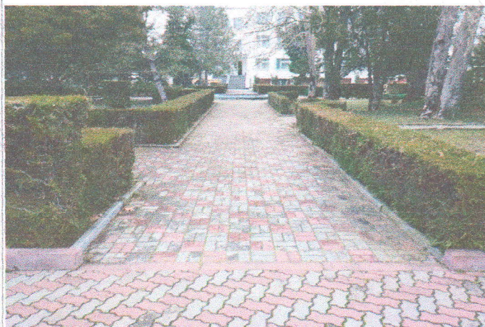
Фото № 10 – Пути движения по территории корпус №2
