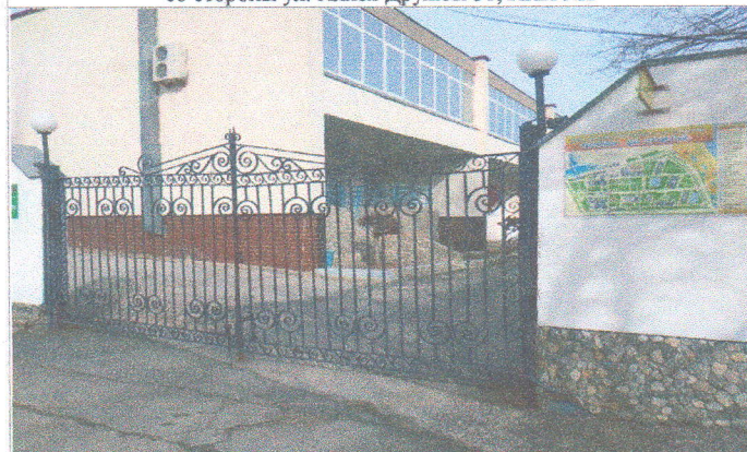
Фото №5 – Вход на территорию дополнительный со стороны пер. Межлагерный проезд, КПП №2
