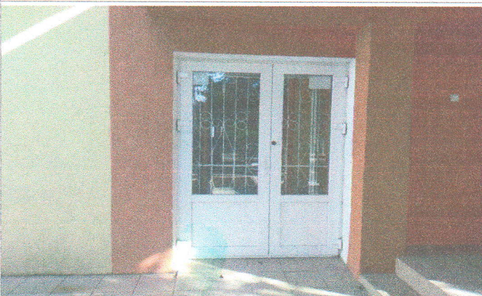
Фото №39 - Дверь в здание запасная (эвакуационная)
