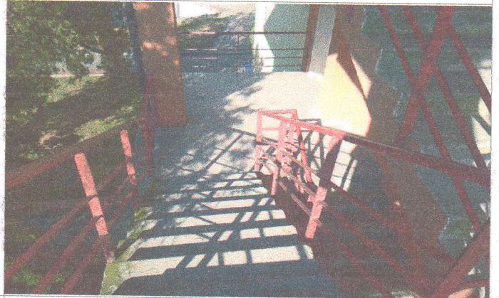
Фото № 44 - лестница эвакуационная
