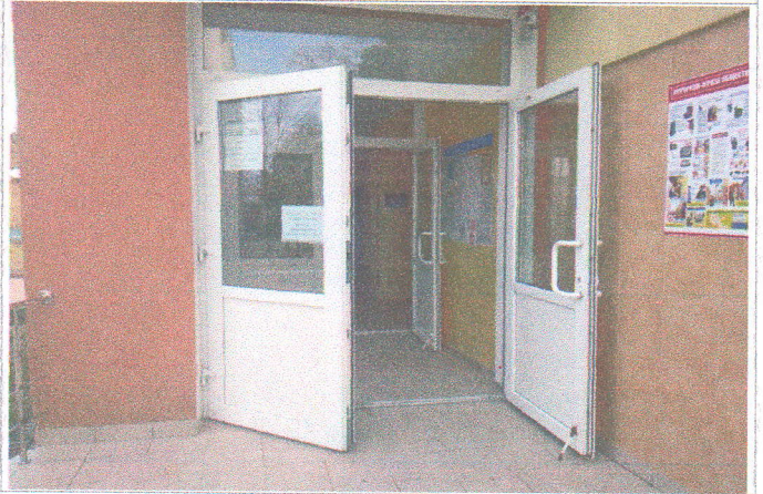
Фото №28 – Входные двери (центральный вход)
