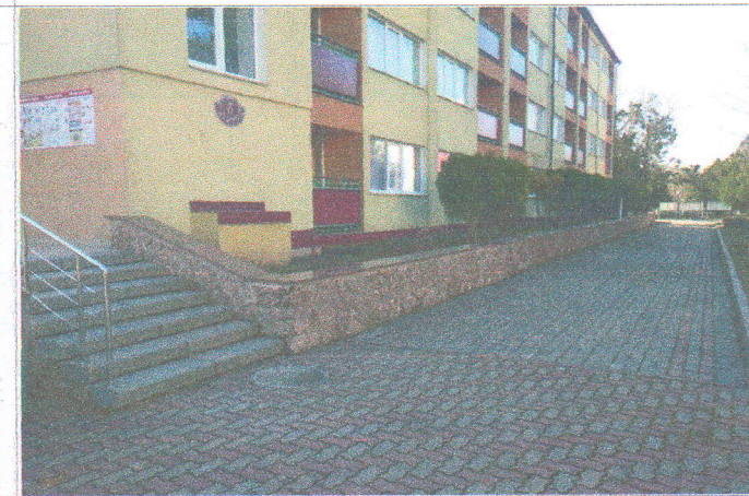
Фото №24 – вход в корпус №5 (путь следования)
