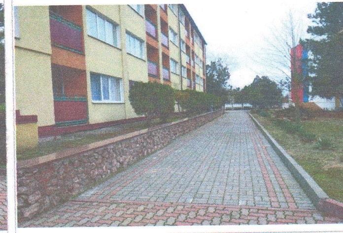
Фото №16 – Пути движения по территории корпус №5
