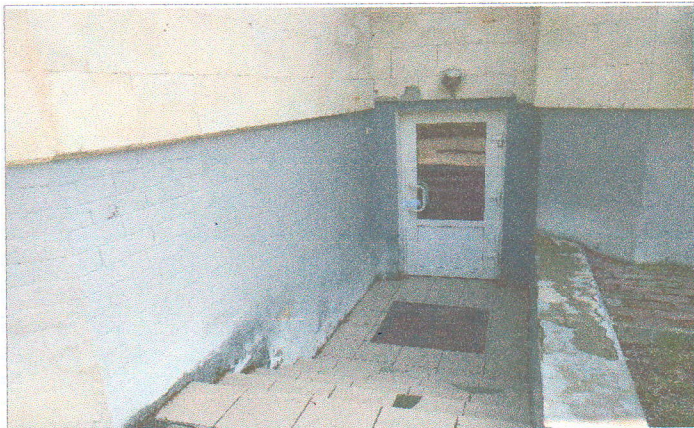
Фото № 57- эвакуационный вход в корпус цокольный этаж с ( правой стороны)
