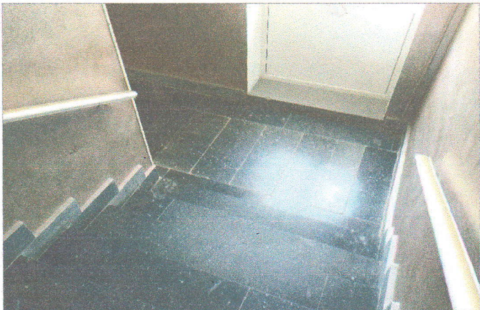
Фото №33 – лестничный марш на этажи (центральный)
