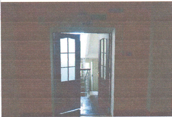
Фото № 69- выход на лестничный эвакуационный марш (боковой)
