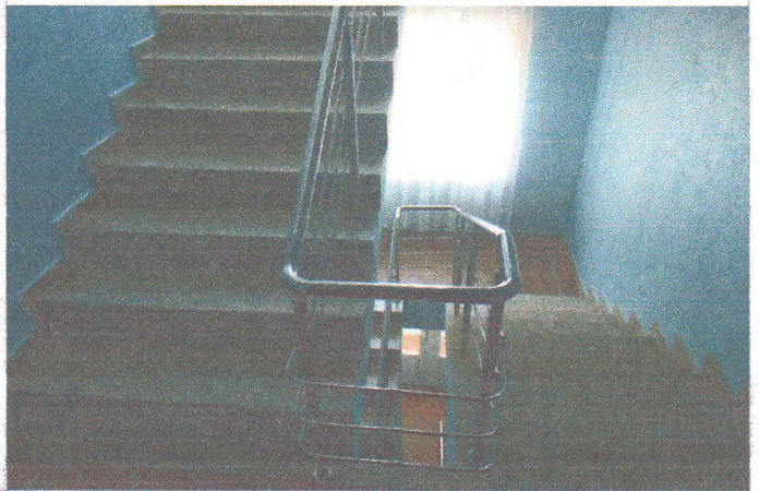
Фото № 42- лестничный марш эвакуационного выхода (правая сторона)
