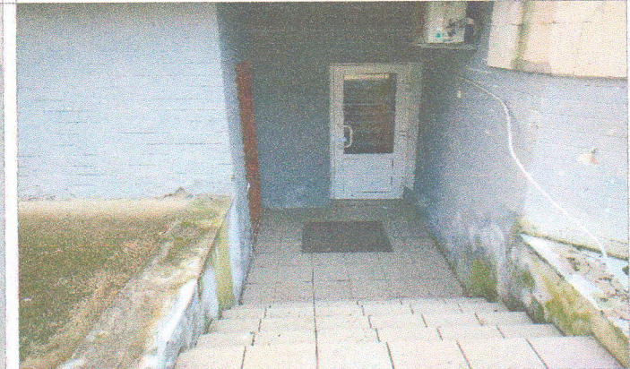
Фото № 56- эвакуационный вход в корпус цокольный этаж (центральный)
