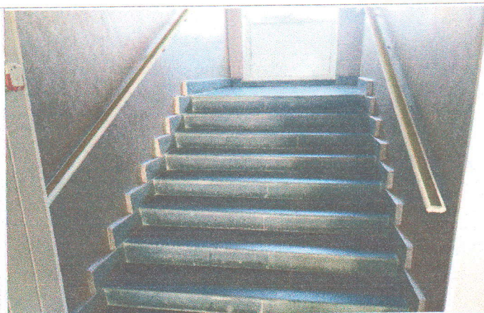
Фото №30 — лестничный марш на этажи (центральный)
