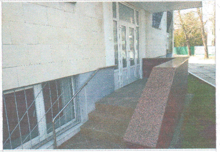
Фото № 50- вход в корпус эвакуационный (с правой стороны)
