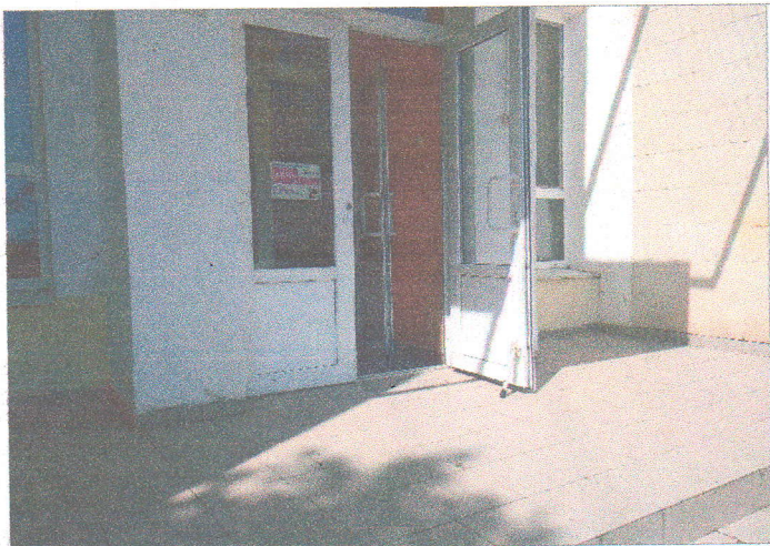
Фото №25 — входная площадка перед центральной дверью
