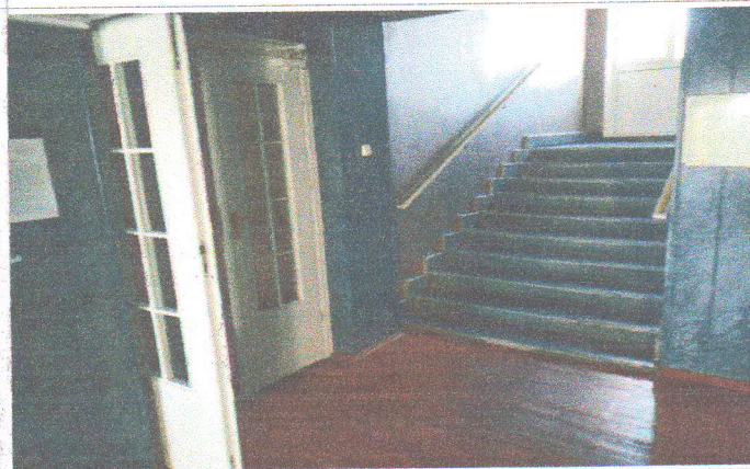
Фото №32 — лестничный марш на этажи (центральный)
