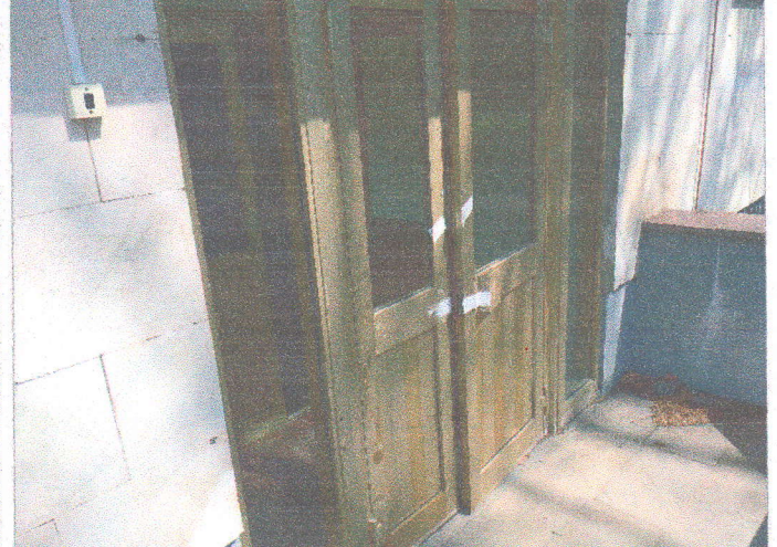
Фото № 52- эвакуационный вход с (левой стороны корпуса)
