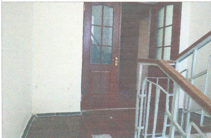
Фото №35 - лестничный марш эвакуационного выхода (левая сторона)
