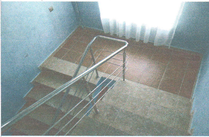
Фото № 41- лестничный марш эвакуационного выхода (правая сторона)
