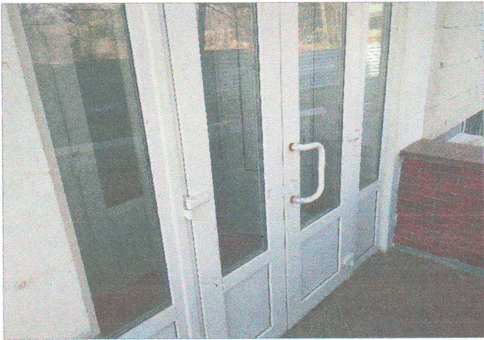
Фото № 49- вход в корпус эвакуационный (с правой стороны)
