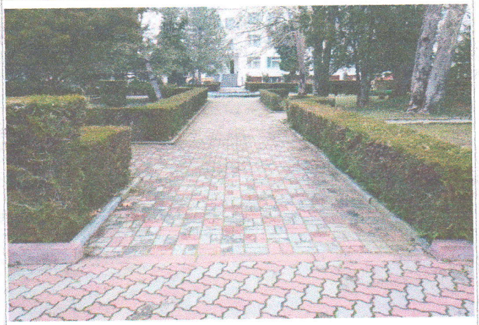
Фото № 10 – Пути движения по территории корпус №2
