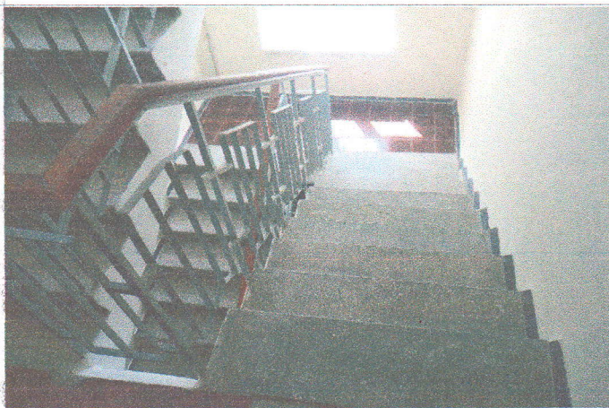
Фото №36 - лестничный марш эвакуационного выхода (левая сторона)
