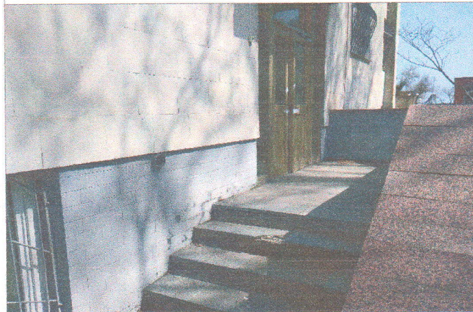
Фото № 53- эвакуационный вход в корпус с (левой стороны)
