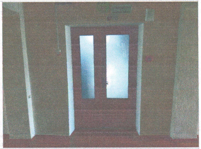
Фото № 66- выход на лестничный эвакуационный марш (боковой)
