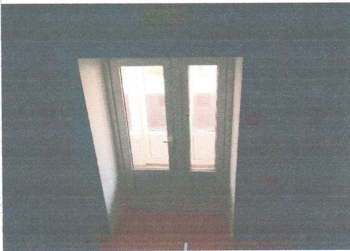
Фото № 51- выход из корпуса эвакуационный (с правой стороны)
