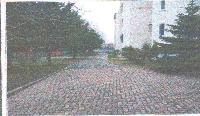
Фото №14 – Пути движения по территории корпус №4
