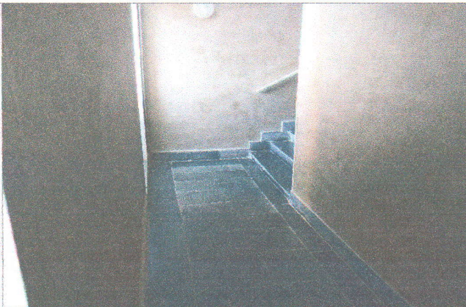
Фото №34 – лестничный марш на этажи (центральный)
