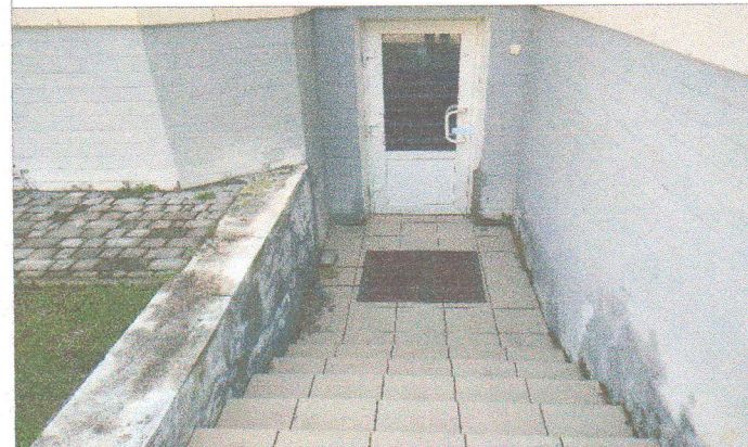
Фото № 55- эвакуационный вход в корпус цокольный этаж с (левой стороны)
