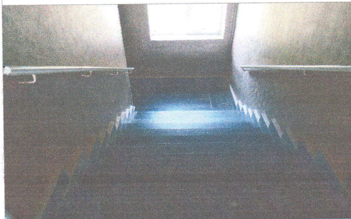
Фото №31 — лестничный марш на этажи (центральный)
