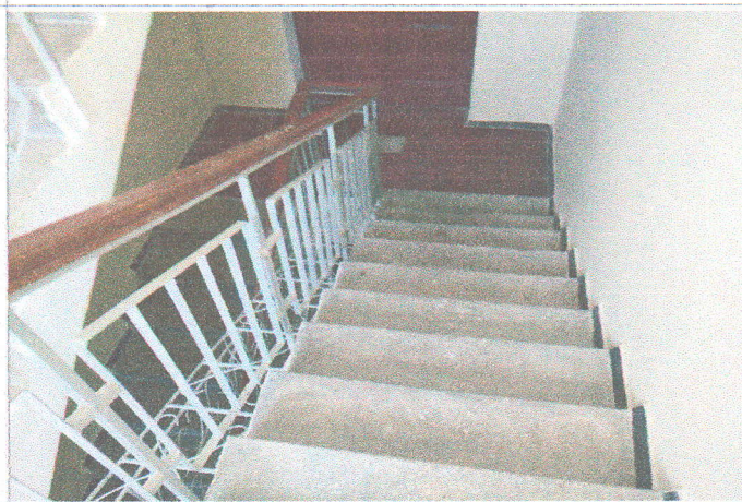
Фото №38 - лестничный марш эвакуационного выхода (левая сторона)
