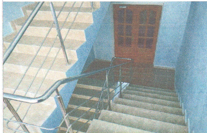
Фото № 40 – лестничный марш эвакуационного выхода (правая сторона)
