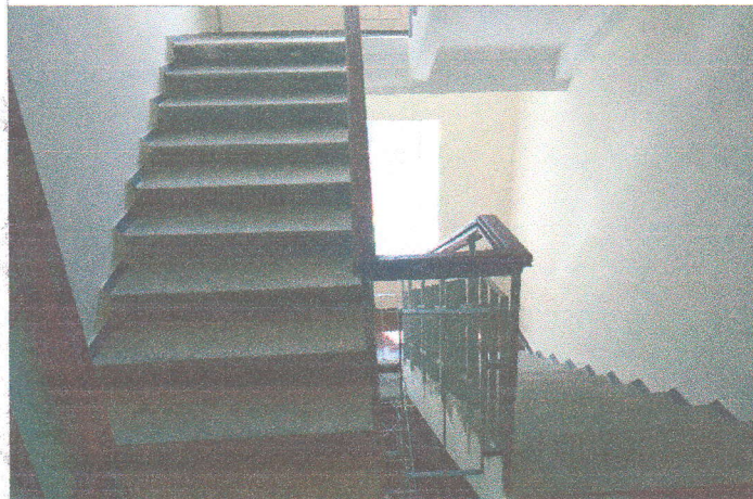
Фото №37 - лестничный марш эвакуационного выхода (левая сторона)
