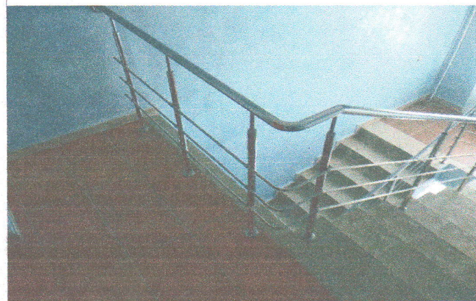
Фото №39 – лестничный марш эвакуационного выхода (правая сторона)
