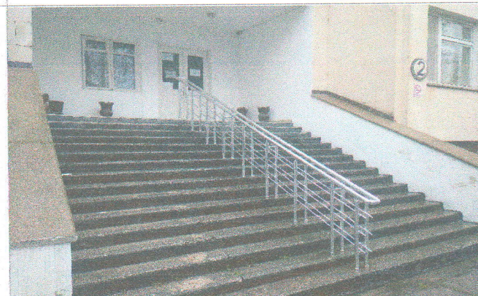
Фото №24 – вход в корпус №2 (центральный)
