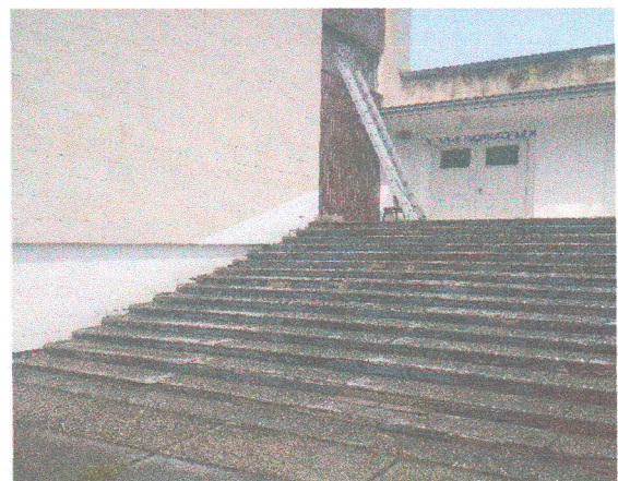
Фото № 56- лестница и входная дверь эвакуационная правая
