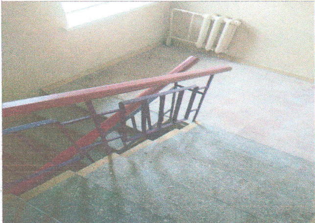
Фото № 51- лестничный марш второй этаж эвакуационный левый
