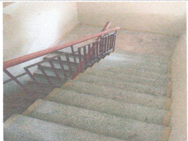
Фото № 52- лестничный марш третий этаж эвакуационный левый
