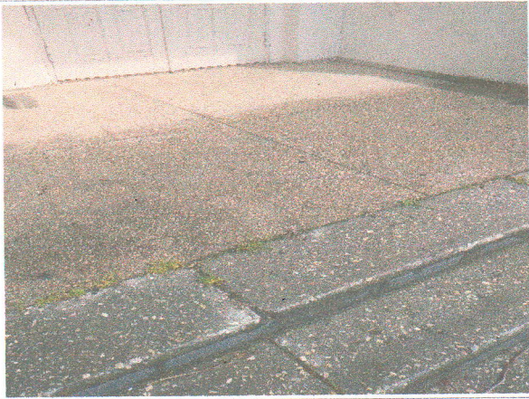
Фото № 57- лестничная площадка перед входом эвакуационным правая
