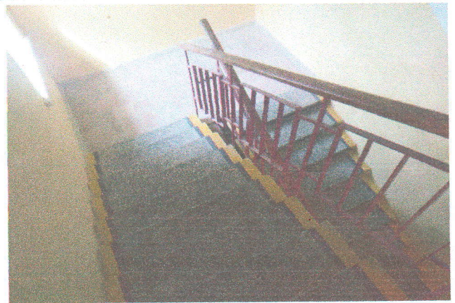
Фото № 44- лестничный марш второго этажа центральный
