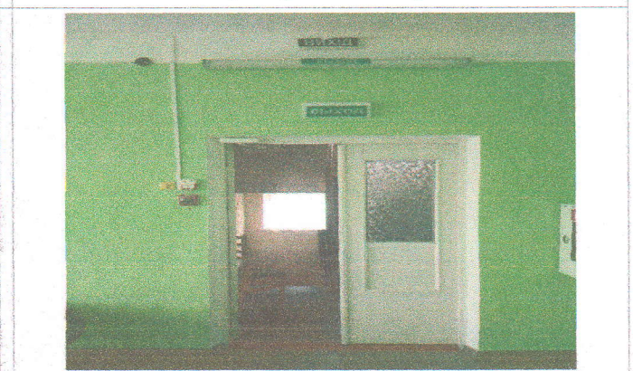
Фото №32 — дверь второго этажа эвакуационный выход правый
