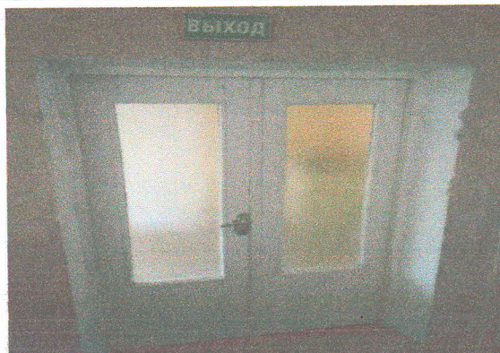
Фото №36 – дверь третьего этажа эвакуационный выход правый
