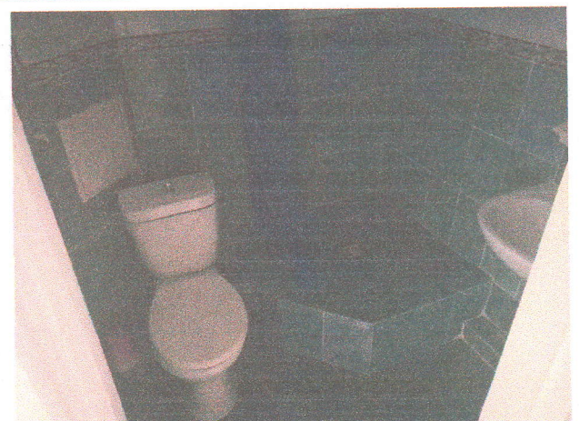
Фото № 64- санитарно – гигиеническое помещение в номере
