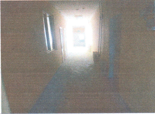
Фото № 41- коридор второго этажа
