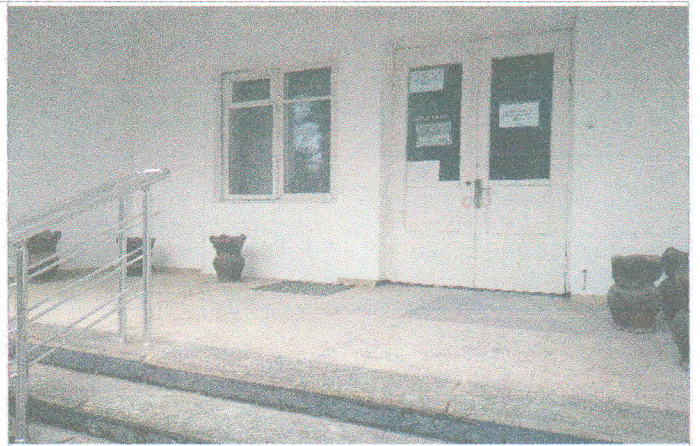
Фото №26 — площадка перед входом в корпус №2
