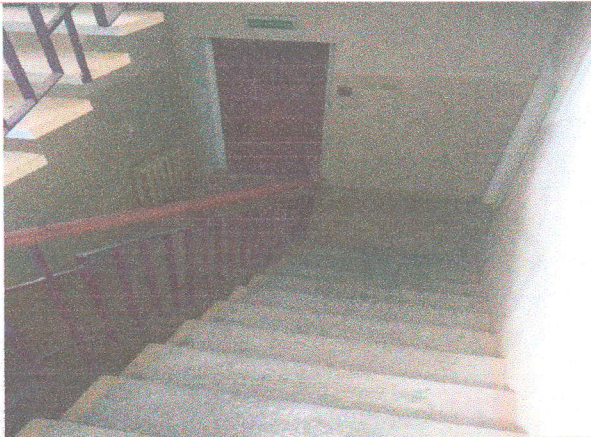
Фото № 53- лестничный марш первый этаж эвакуационный левый
