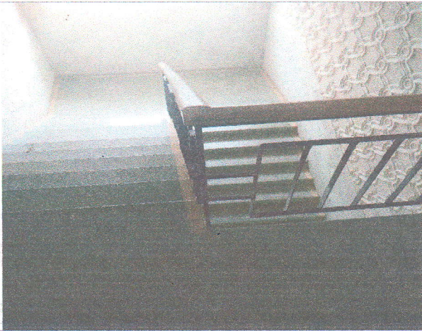
Фото № 49- лестничный марш третий этаж эвакуационный правый
