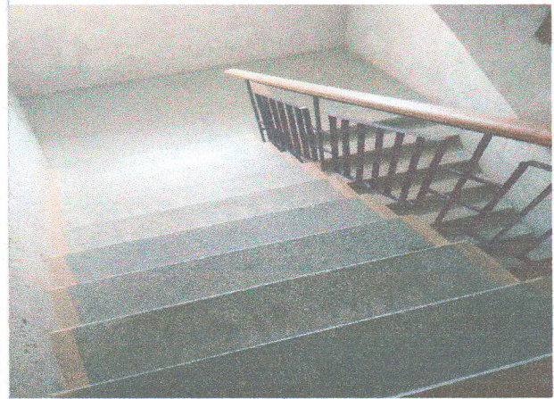
Фото № 50- лестничная площадка (эвакуационный) правый
