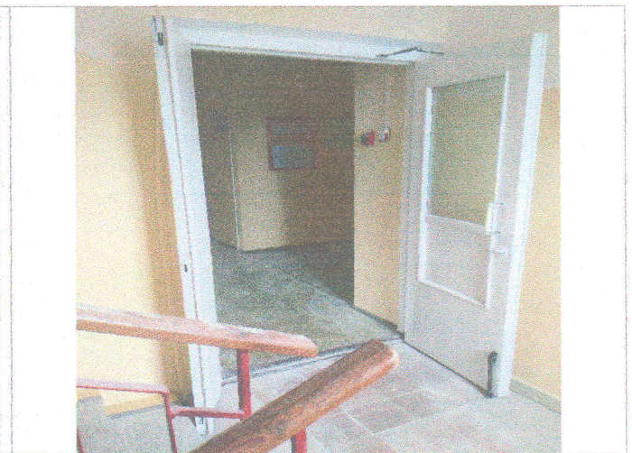
Фото №30 — дверь второго этажа центрального входа
