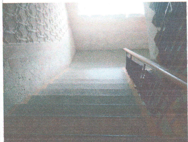
Фото № 48- лестничный марш второй этаж эвакуационный правый
