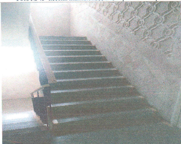
Фото № 47- лестничного марш первый этаж эвакуационный правый
