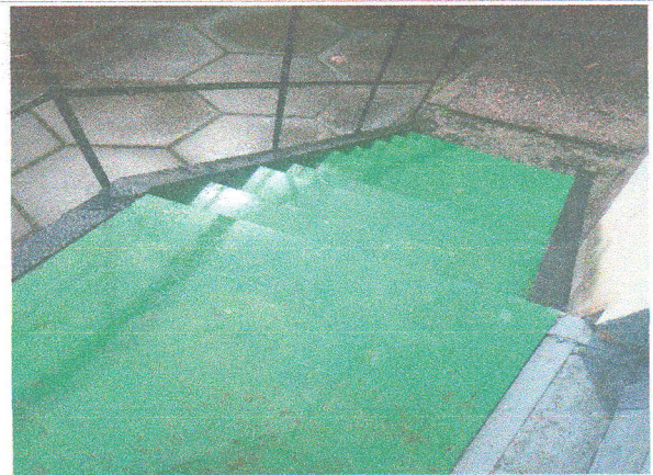
Фото № 54- входная лестница эвакуационного марша левая
