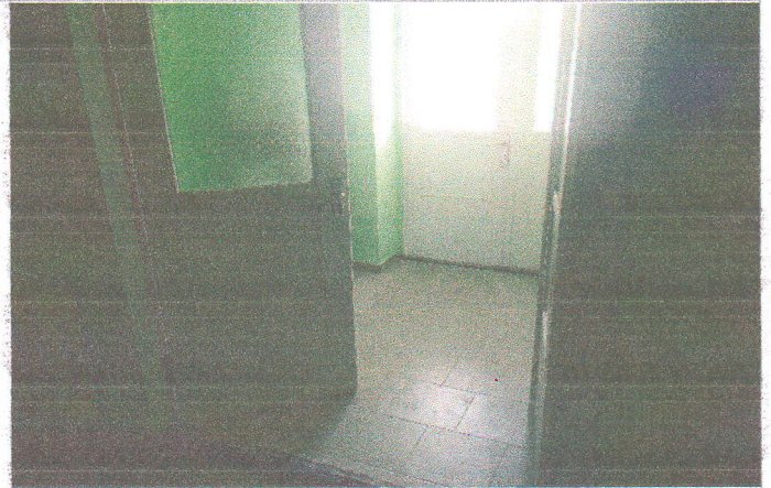
Фото №28 — тамбур вид из коридора
