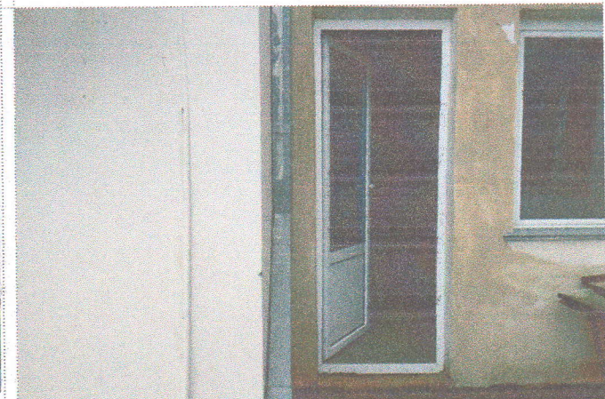
Фото №38- вход (выход) эвакуационный №2
