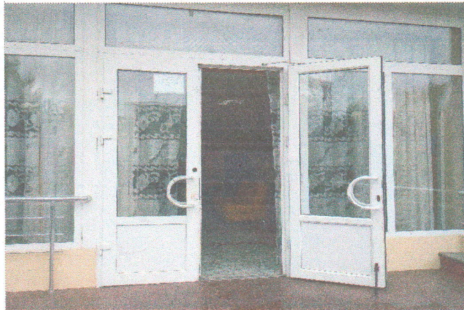
Фото №27 — входная дверь центрального входа
