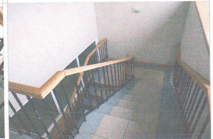
Фото № 48- лестничный марш на первый этаж
