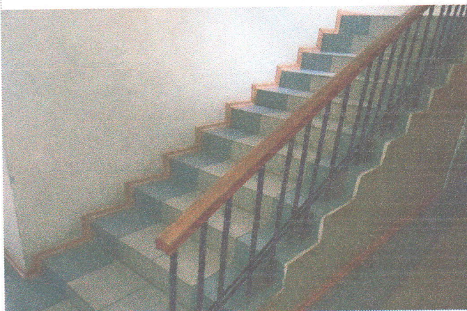
Фото № 45- лестничный марш первый этаж
