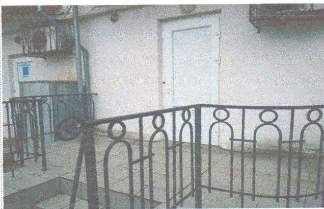
Фото №37 - вход (выход) эвакуационный №3
