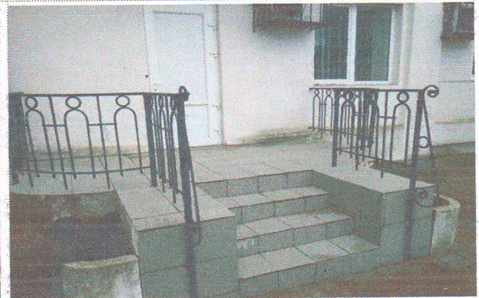
Фото №36 – вход (выход) эвакуационный №3
