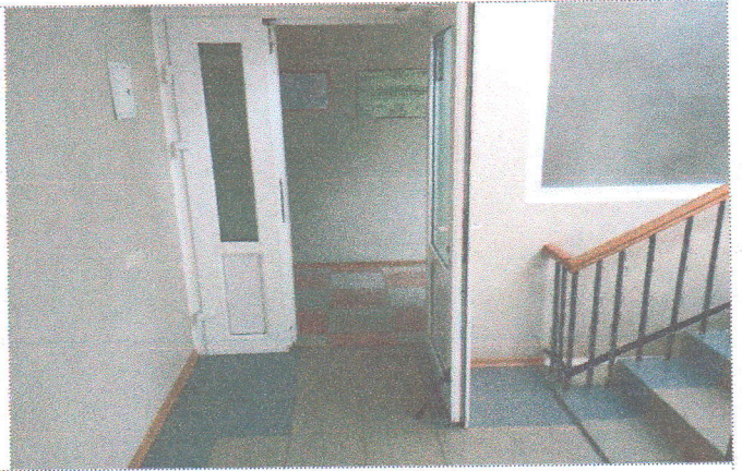
Фото № 42- двери и лестничная площадка второго этажа
