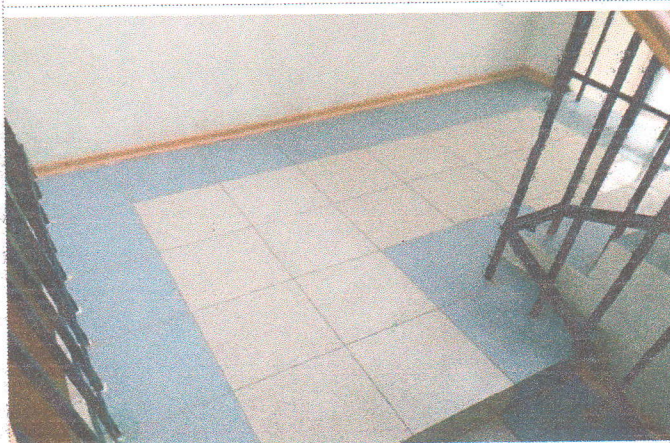
Фото № 47- площадка лестничного марша
